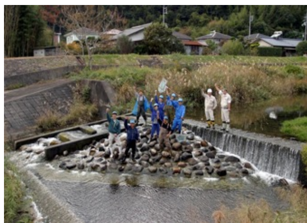
漁業者・山口県・水産大学校の産学官が協働して つくった樫野川『水辺の小わざ』魚道
