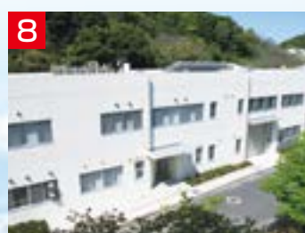
船用機械総合実験棟
