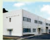
船用機械総合実験棟
