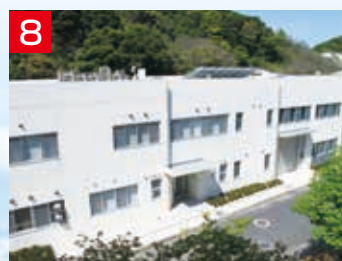
船用機械総合実験棟
