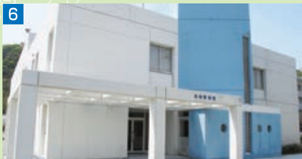
▲ 舟艇管理棟 平成8年度建築 RC2階建 1,217.58㎡
