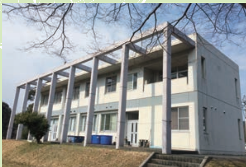
宿舎 兼 研究棟
