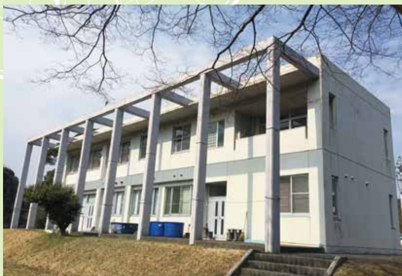
宿舎 兼 研究棟
