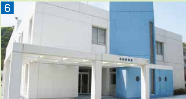
▲ 舟艇管理棟 平成8年度建築 RC2階建 1,217.58㎡
